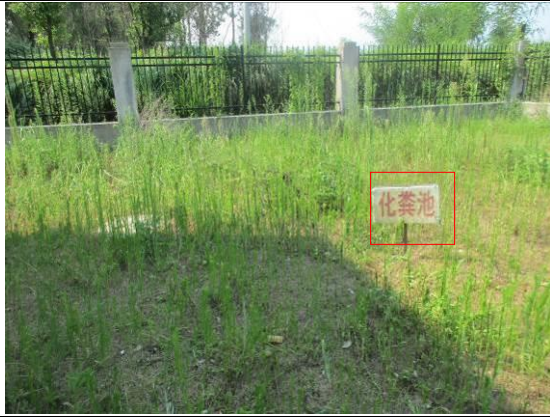
光伏电站办公区设置的化粪池
