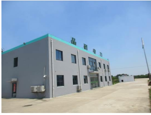
光伏电站生活区办公楼
