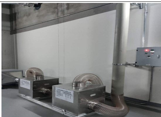
印刷废气处理装置
