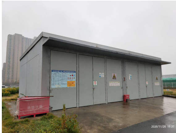
图 3-3 危险废物暂存仓库
