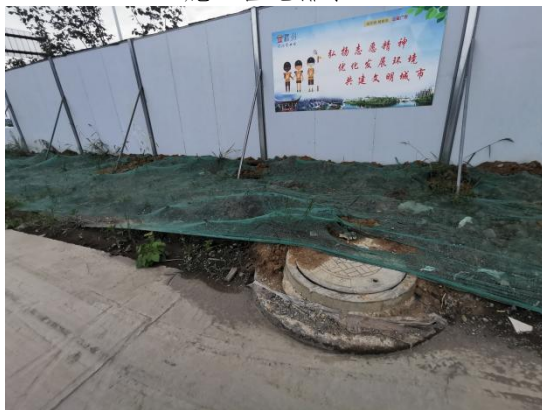
施工营地表土遮盖
