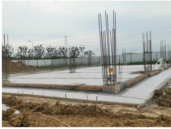
主体工程区基础底板混凝土浇筑
