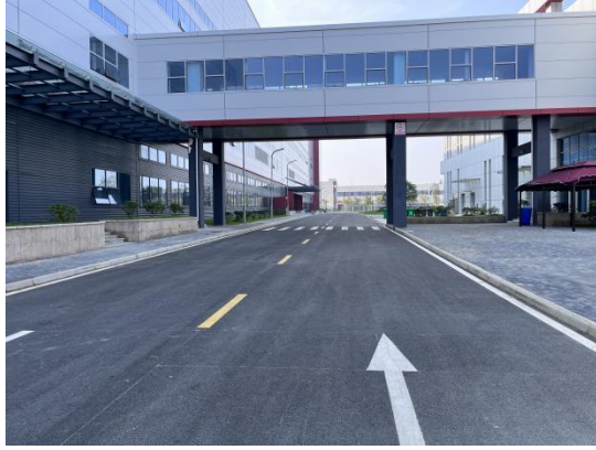
主体工程区道路
