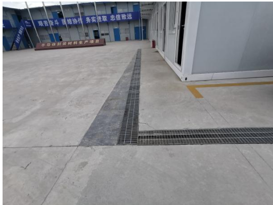
施工营地排水
