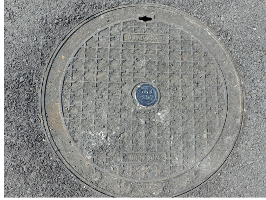
主体工程区雨水井
