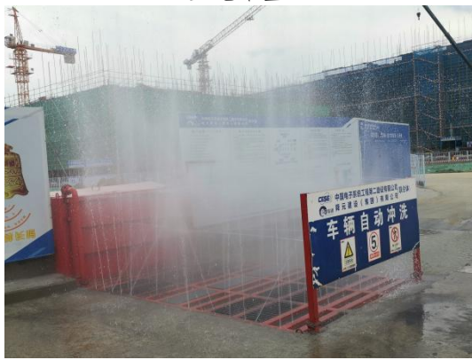
施工场地车辆进出清洗场所
