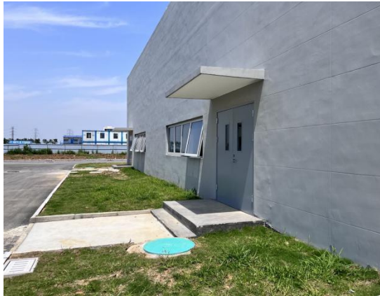
主体工程区绿化
