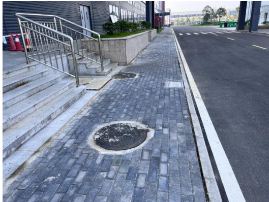
主体工程区雨水管道
