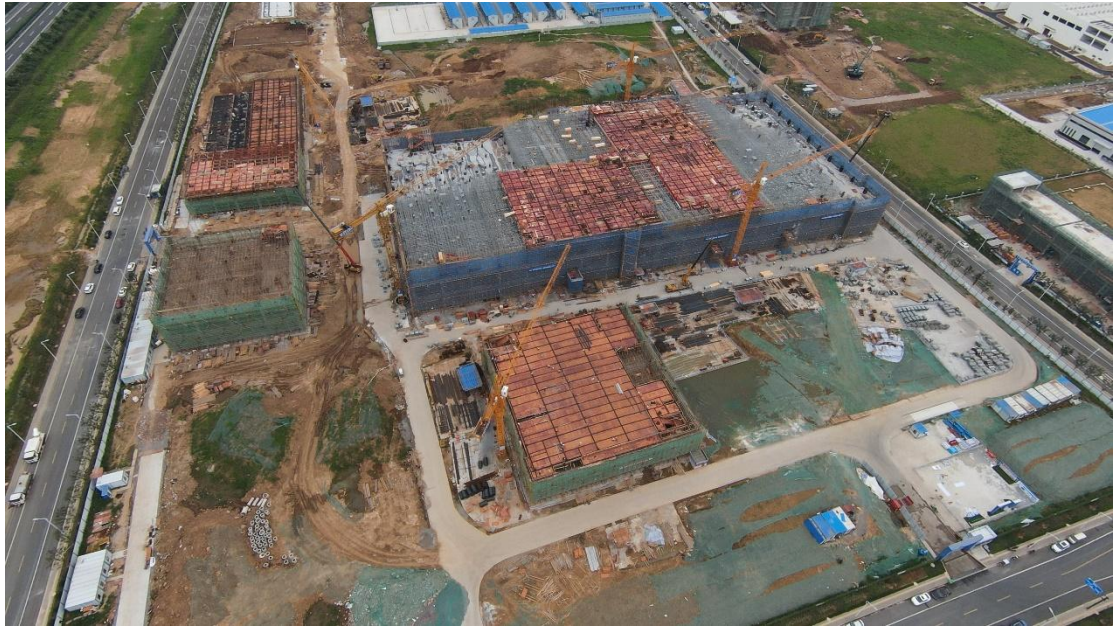
项目施工期航拍图
