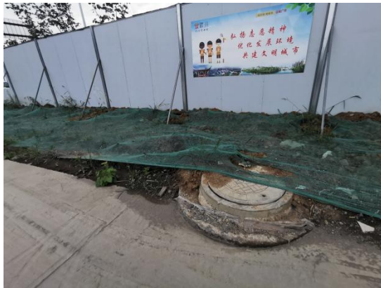
施工营地表土遮盖
